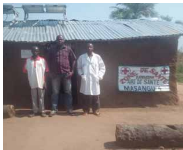
Nouveau bâtiment du CS Masngu AnayilZS de Kamuesha
