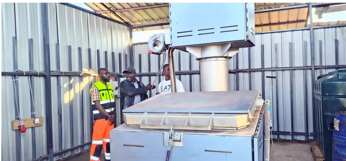
Installation d'un incinérateur des déchets biomédicaux dans le Bandundu
